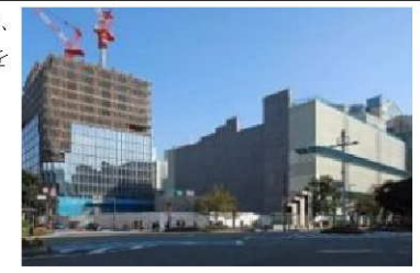
【福ビルが解体され奥に見える天神ビジネスセンター(仮)には、ジャパネットホールディングスが入居予定】
